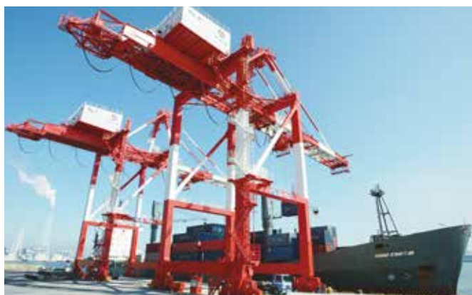
ガントリークレーン
