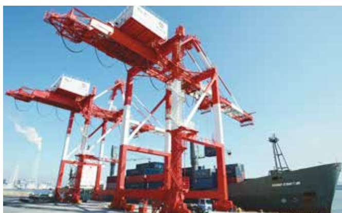
ガントリークレーン
